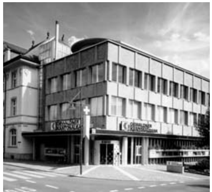
Hauptsitz der Obwaldner Kantonalbank in Sarnen
